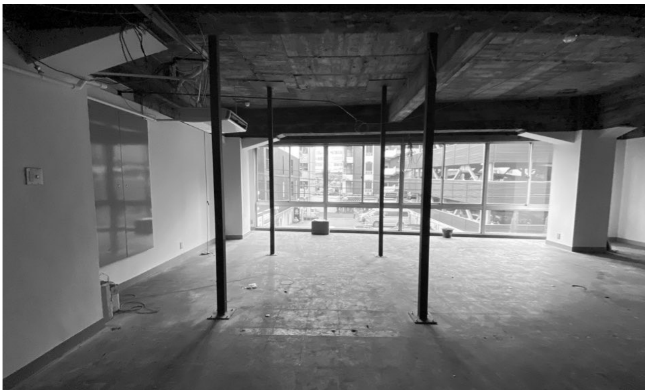
山川ビル2階の様子
